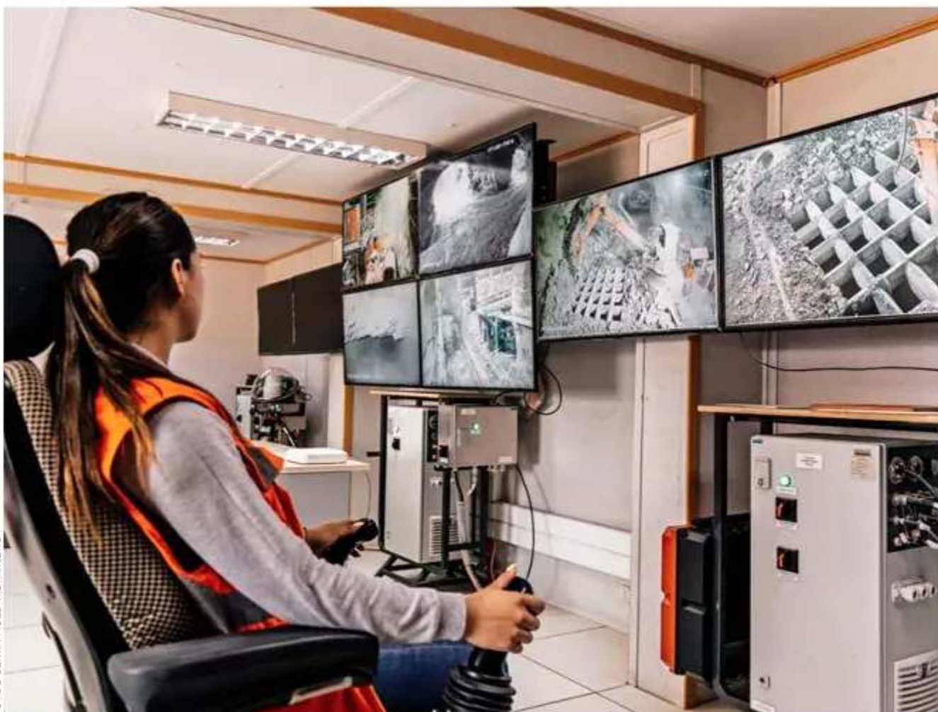
En la Mina Uva subterránea, CEMIN tiene la operación tele-operada desde una sala de control ubicada al exterior de ella, única en la mediana minería.
